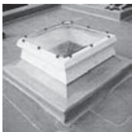
Étanchéité d'une coupole
