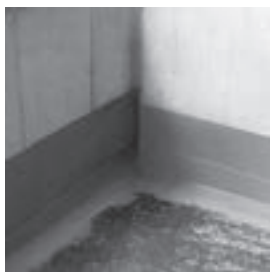
Étanchéité de raccords
