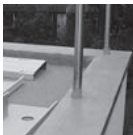
Étanchéité d'une balustrade
